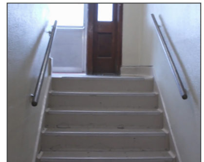
El edificio presenta varios cambios de nivel y solo cuenta con un ascensor, situado en uno de sus laterales, que no llega a la tercera planta.
