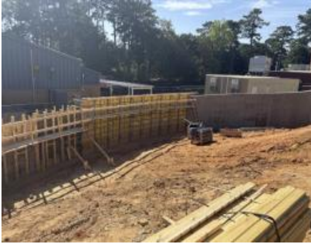
Site Wall B Pour and Forms
