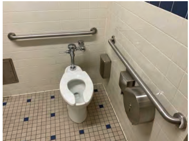
22 - ADA TOILET STALL
