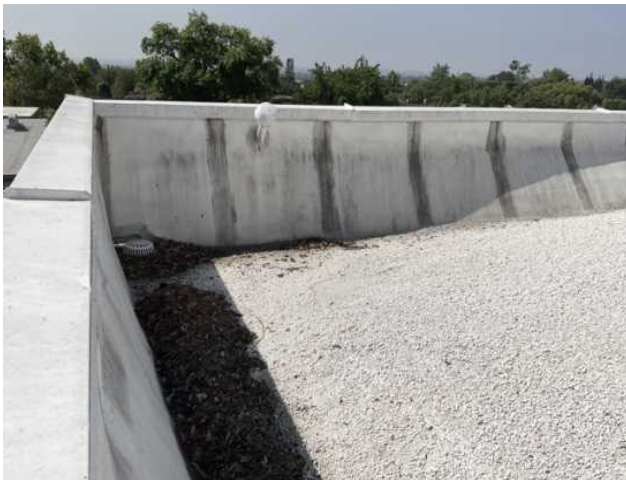
9 - PARAPET WALL EDGE AND FLASHING
