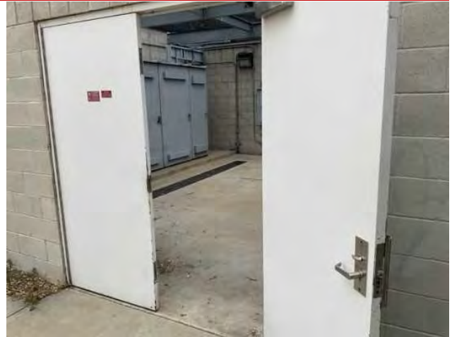
20 - METAL EXTERIOR DOOR
