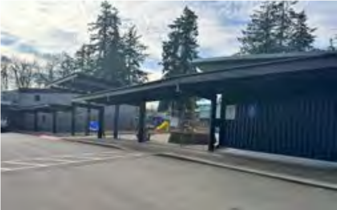
El alumnado camina frente al edificio para llegar al gimnasio / música
