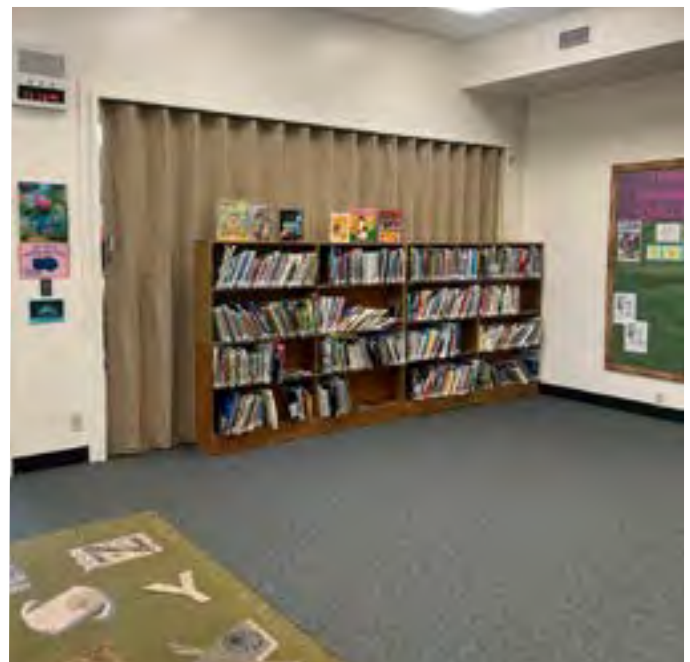
Antiguo muro plegable tipo acordeón entre el salón de intervención y la biblioteca
