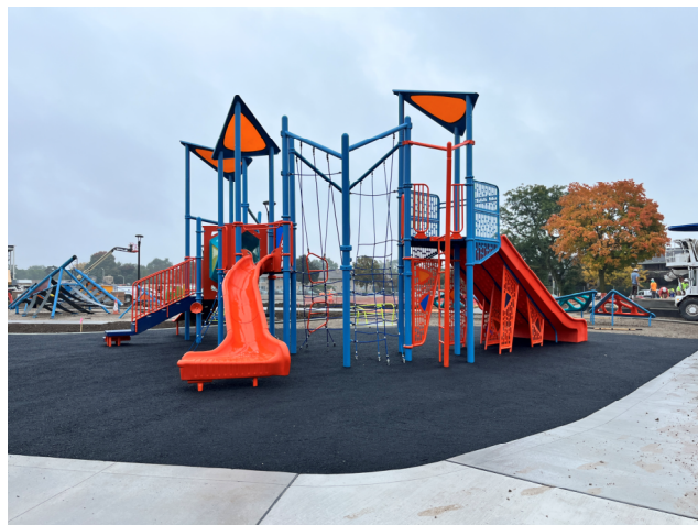
Pour In Place 1 st Layer Installed – Site Playground
