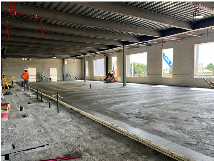
Concrete Pour – Area C1 1st Level
