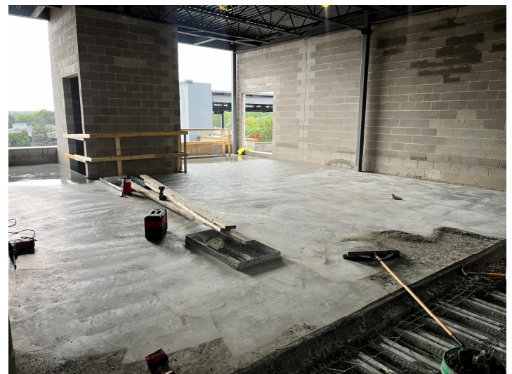
Concrete Pour – Area A2 3 rd Floor
