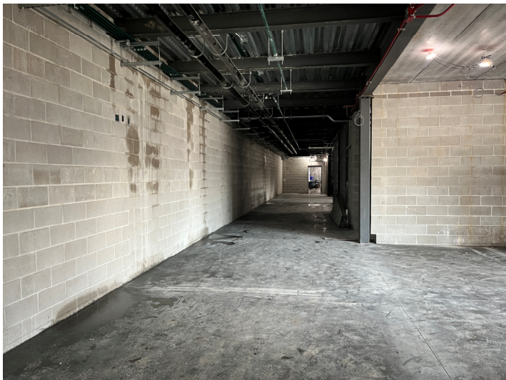
Concrete Pour – Ground Level B1 Corridor
