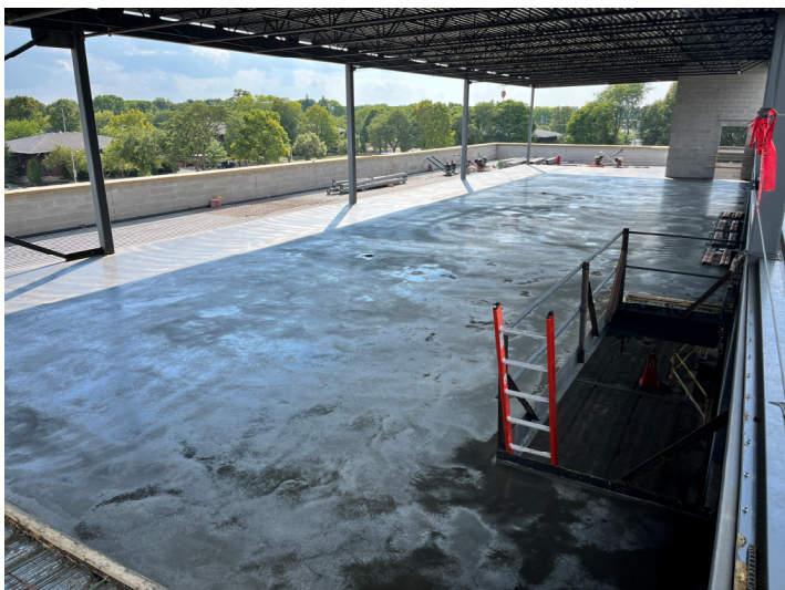
Concrete Pour – Area C1 2 nd Floor
