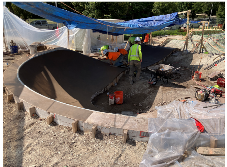
Concrete Pour – Site Pump Track
