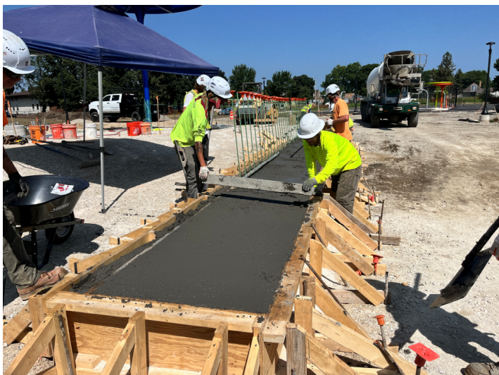
Concrete Pour – Site Pump Track
