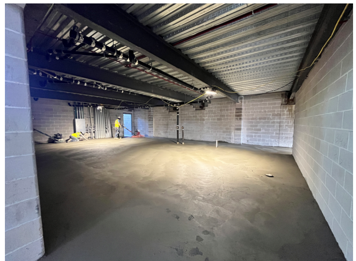
Concrete Pour – Area A2 Ground Level
