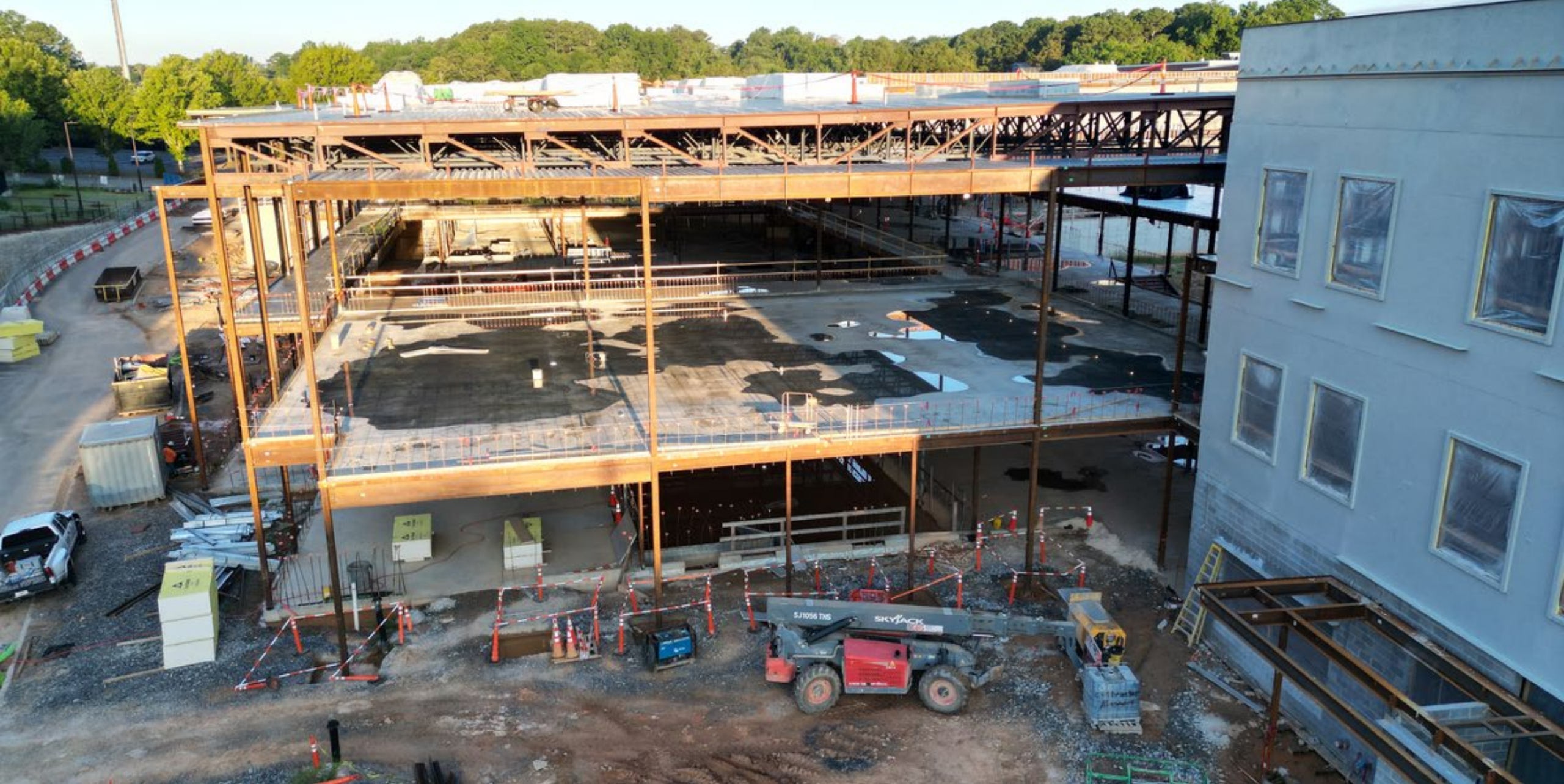
Area 6- Gym- Level 1 Slab pour
