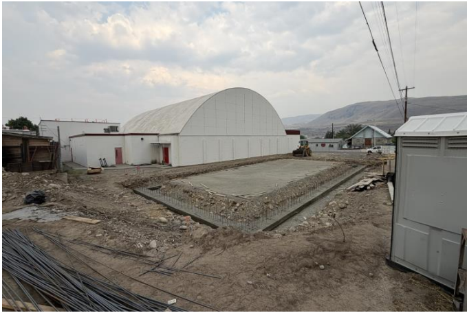
Trabajo de cimentación de la nueva instalación de lucha libre
