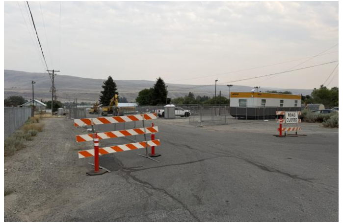
Acceso y preparación del área de construcción
