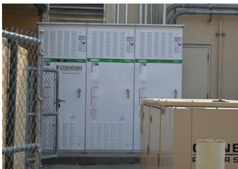
New Switchgear
