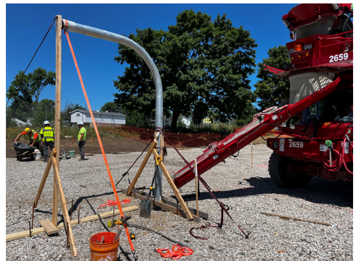
Concrete Pour – Basketball Pole Base – Site
