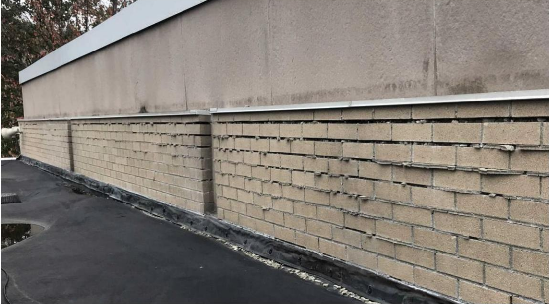
Reparaciones en las paredes exteriores (aquí se muestra la pared sobre el cuarto del ventilador de la piscina).
