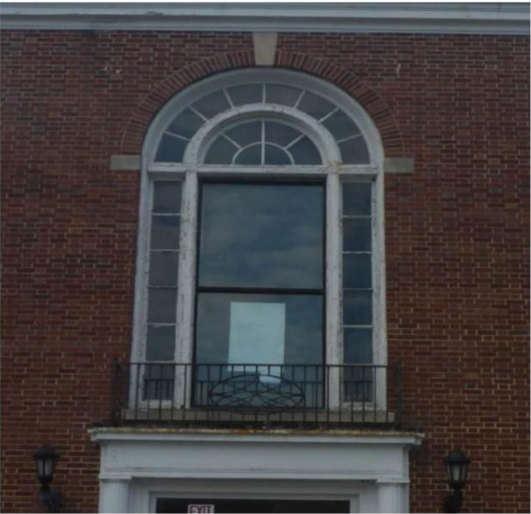
Sustituir las ventanas de la escalera (se muestran aquí las ventanas de la entrada lateral y la entrada principal).
