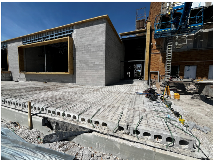
Prepping For Topping Pour – Area B1 Eastside
