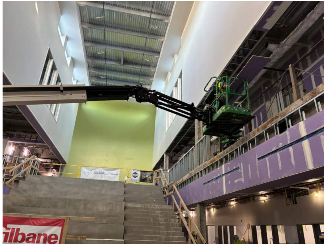
Commons Area Stair & Clerestory – 5/19/26
