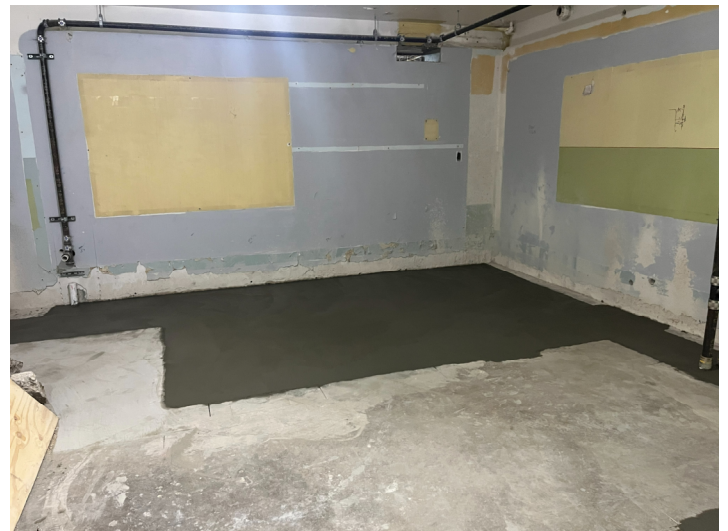
Concrete Slab Pour – Area A1
