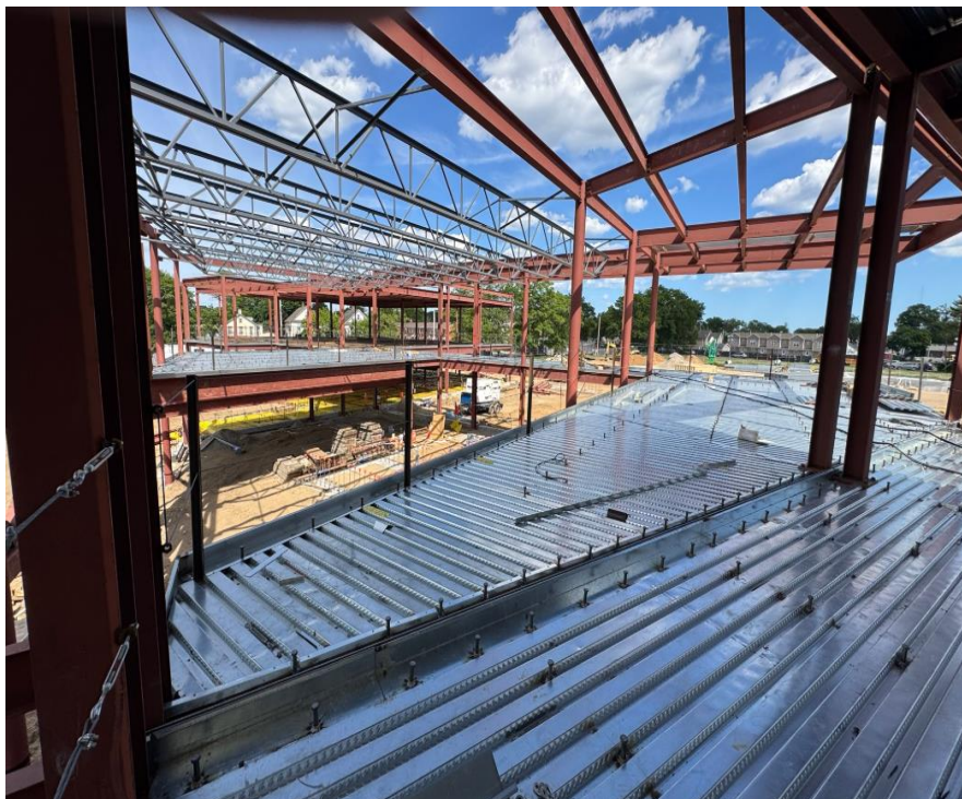
Hempstead ABGS MS – Steel/Decking
