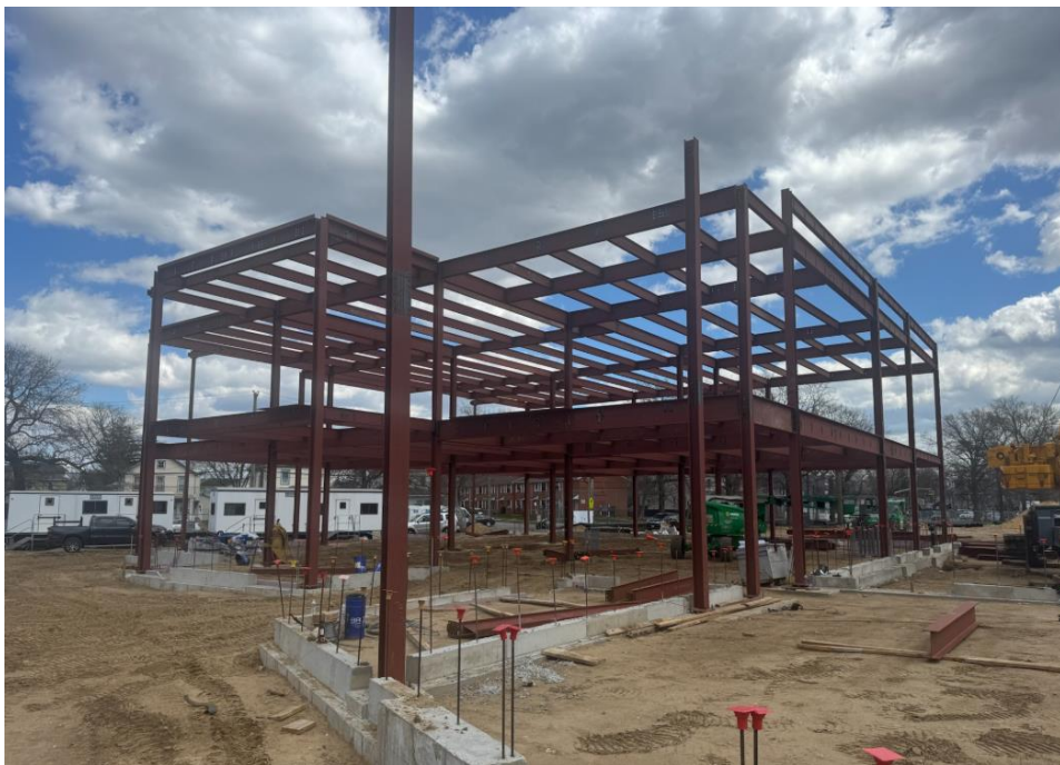
Hempstead ABGS MS – Steel
