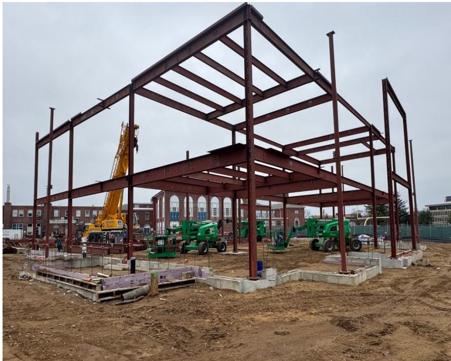
Hempstead ABGS MS – Steel
