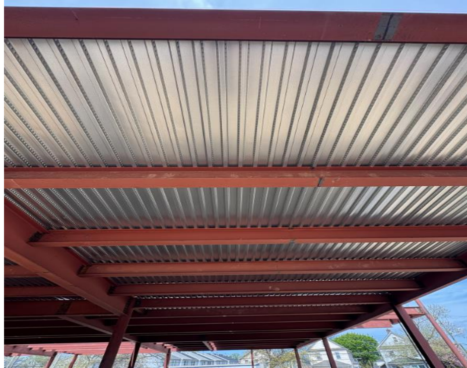
Hempstead ABGS MS – Steel Decking
