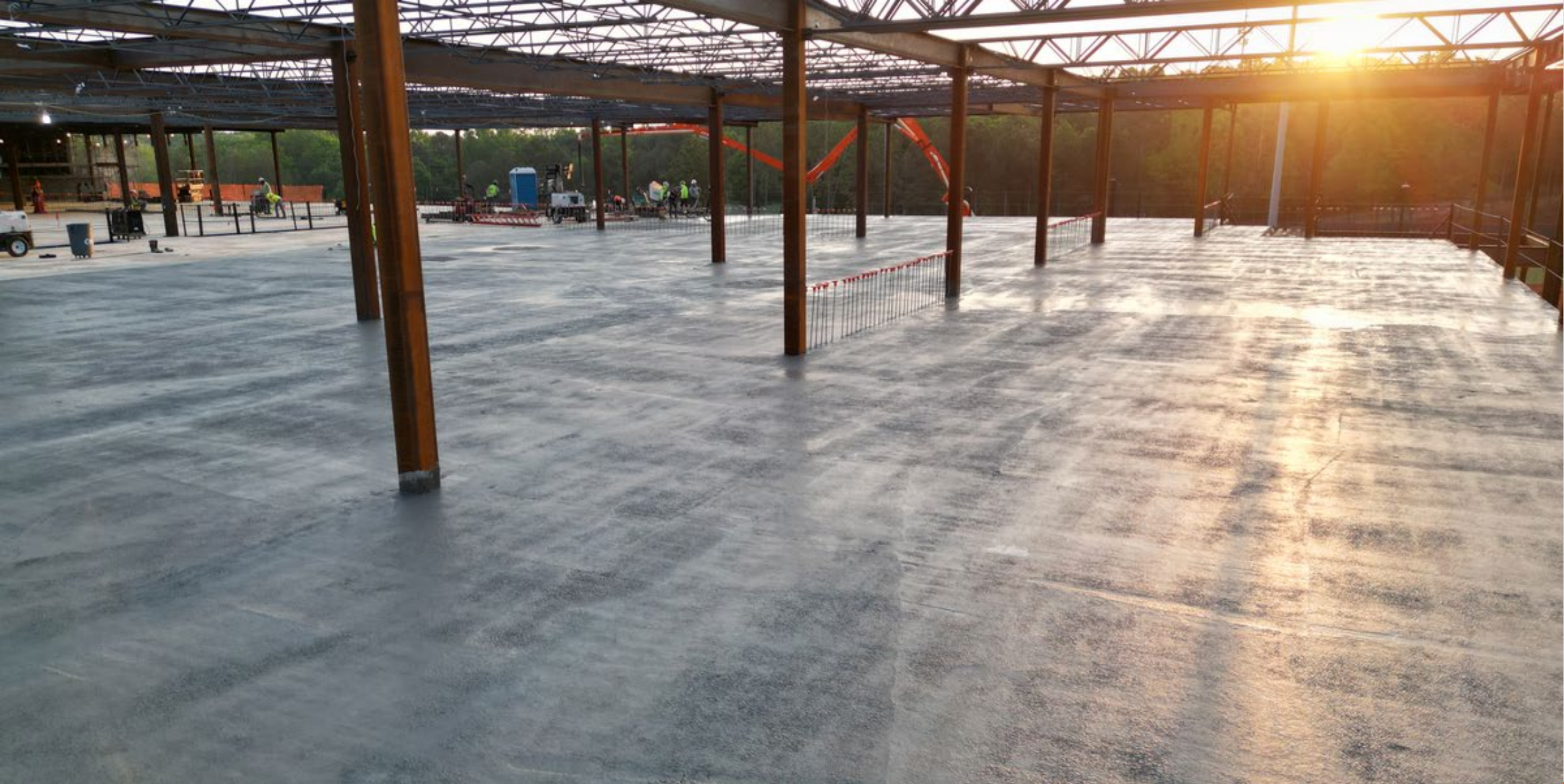
LVL 3 Concrete Pour
