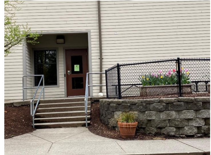
K – 1 Hallway: Door 6
