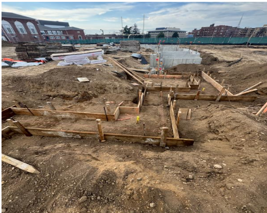
Hempstead ABGS MS – Footings
