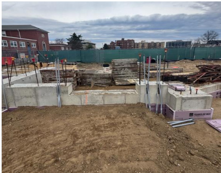
Hempstead ABGS MS – Foundation Walls
