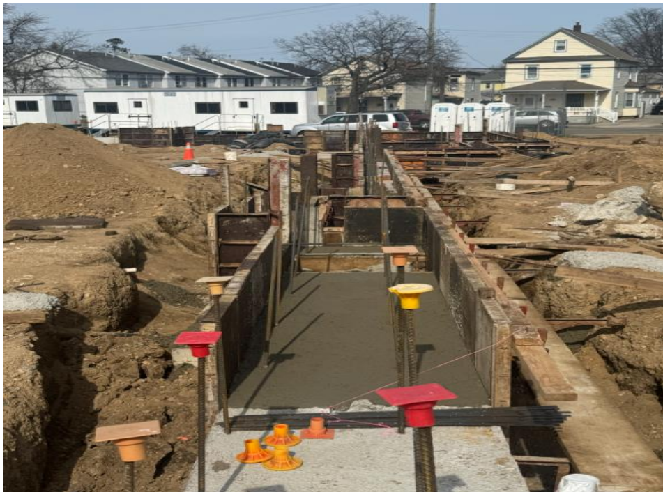
Hempstead ABGS MS – Foundation Walls
