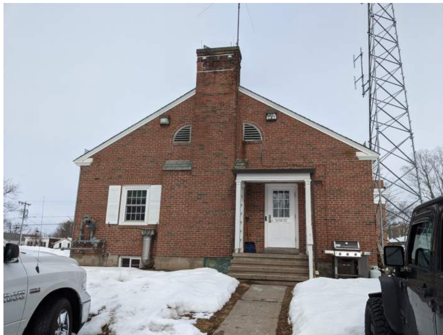
● D1. 4: South façade
