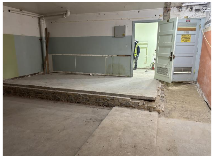
Boiler room ramp demo.
