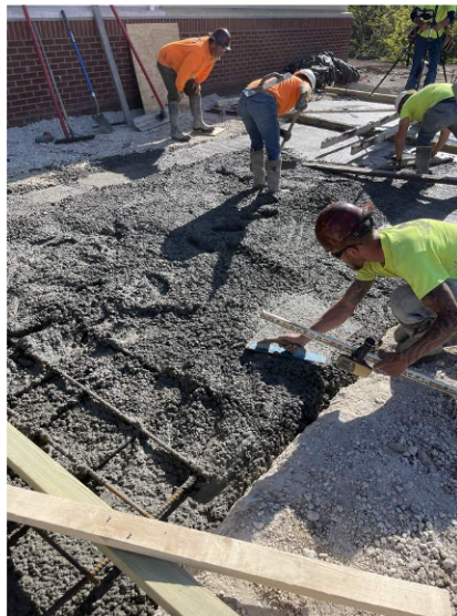
EPiC Elementary - Footing Pour
