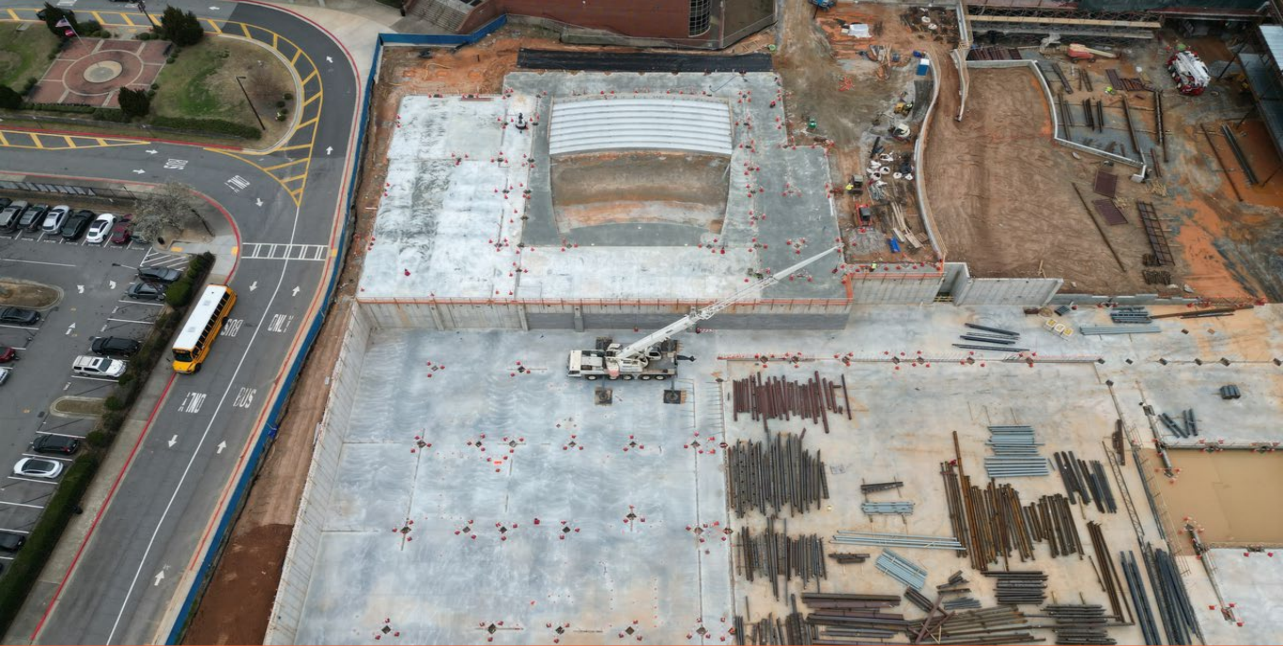
Auditorium (Area 8) Concrete Pour in Progress
