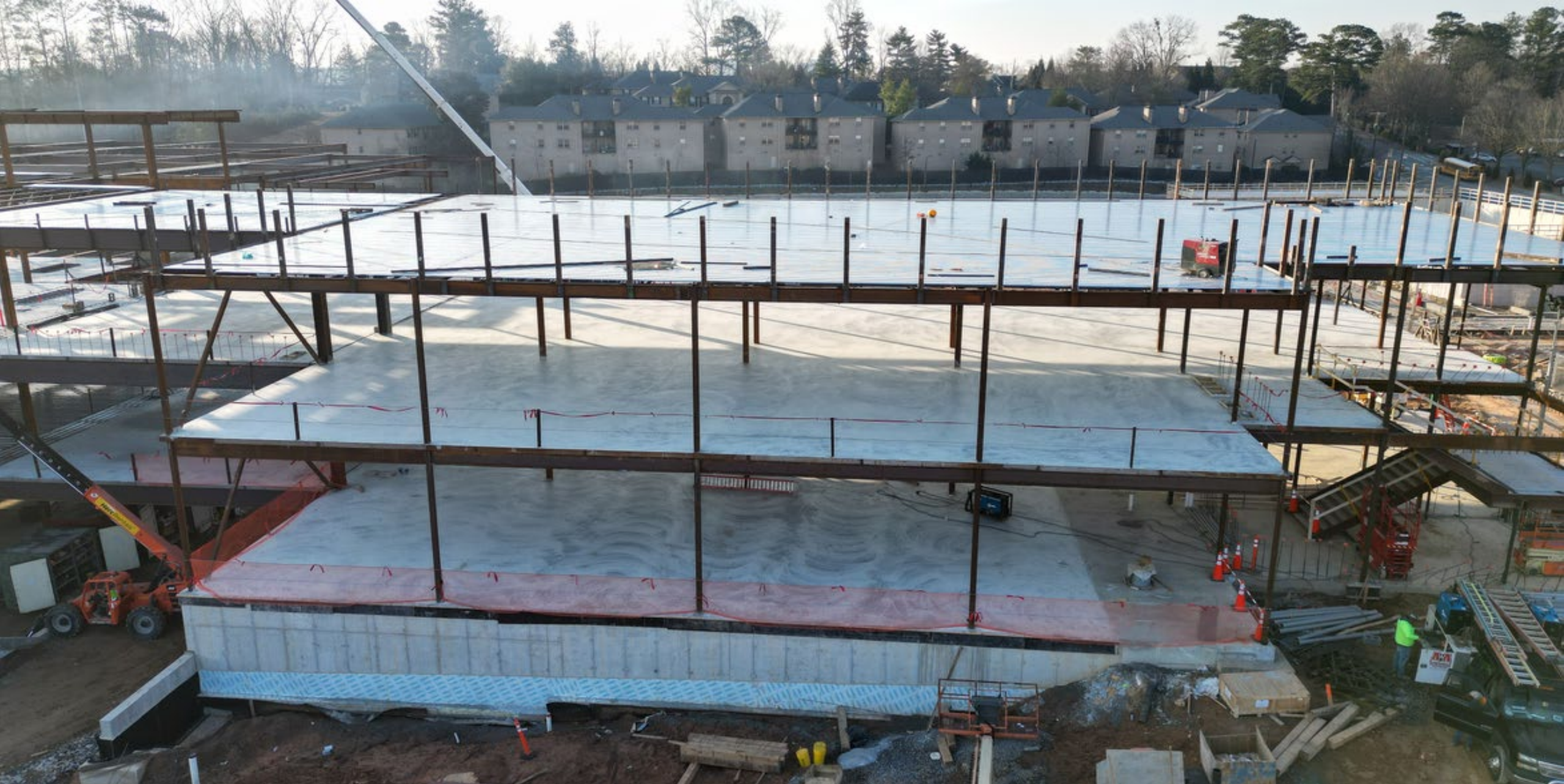
Area '2' Level 2 and 3 Elevated Slab Pour
