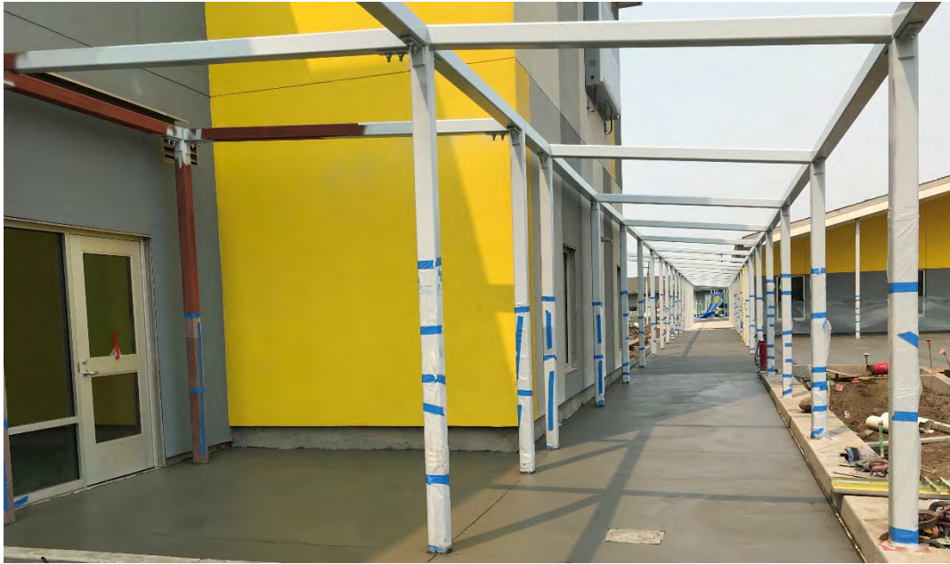
Concrete Pour & Canopy Painting
