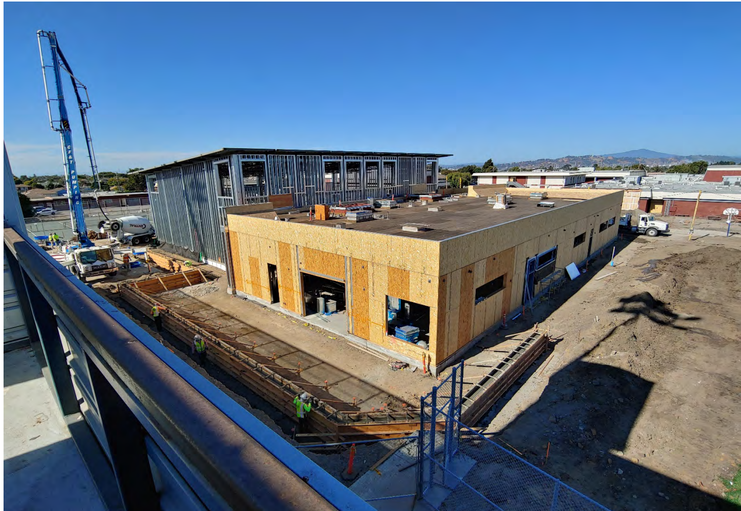
Gym Patio Wall Concrete Pour
