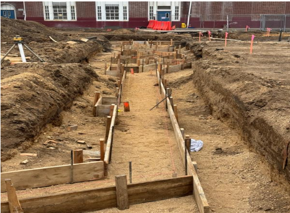
Hempstead ABGS MS – Footings
