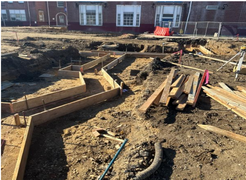
Hempstead ABGS MS – Footings
