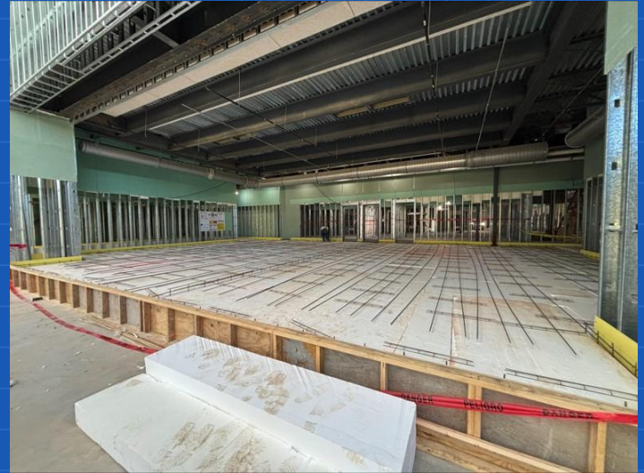
Stage - ready to pour concrete
