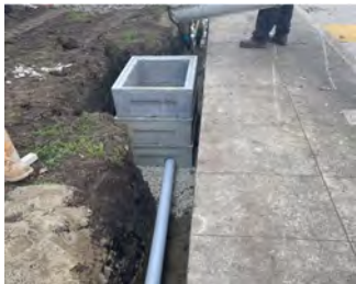
Installing Underground Conduit
