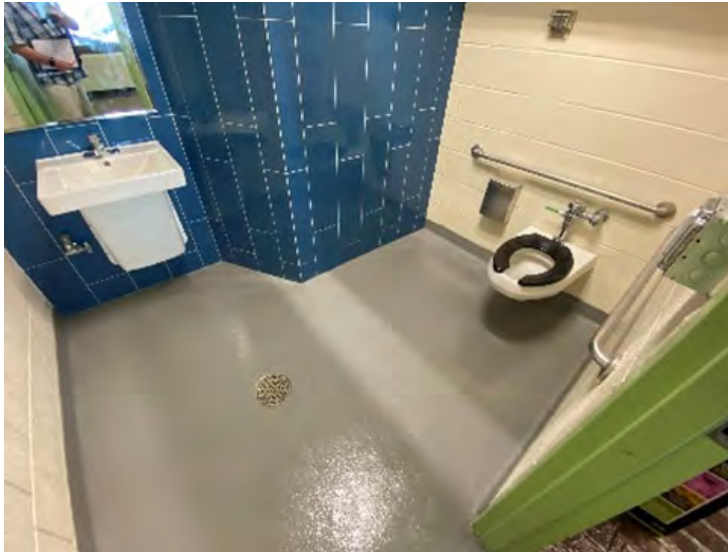
Toilet Room Door
