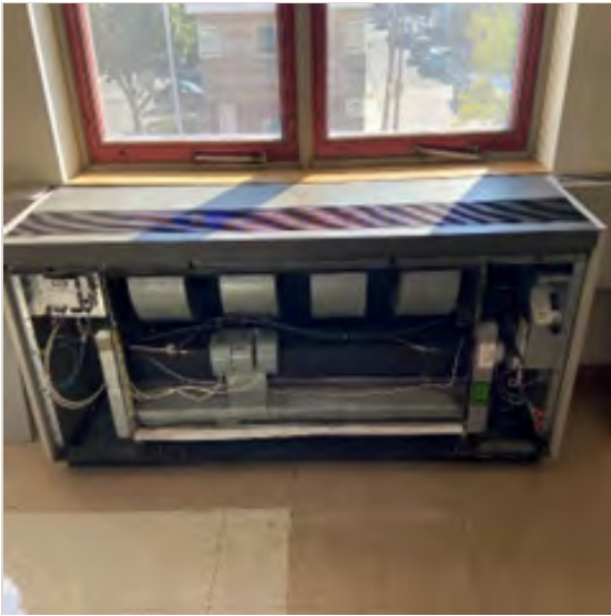
M-6: Unit Ventilator
