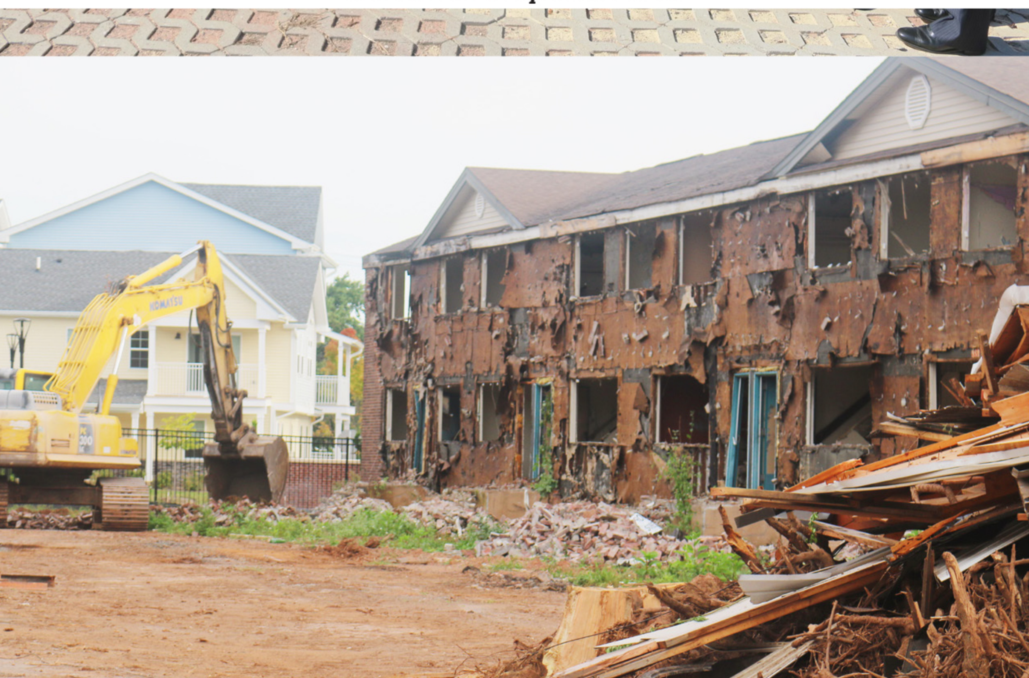
Demolition of Delaney Homes Demolición de Casas Delaney
