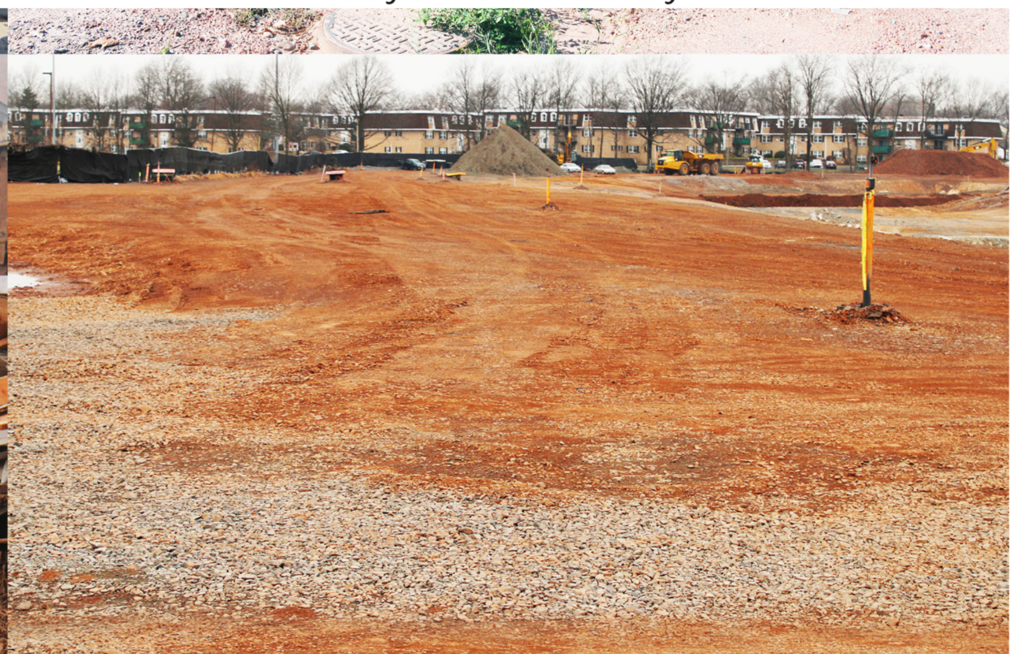
Land prepared for construction to begin Terreno preparado para comenzar la construcción
