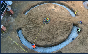
Courtyard footing concrete pour
