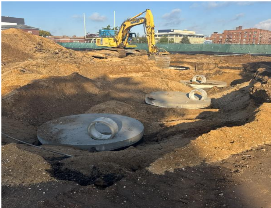
Hempstead ABGS MS – Drainage Pools
