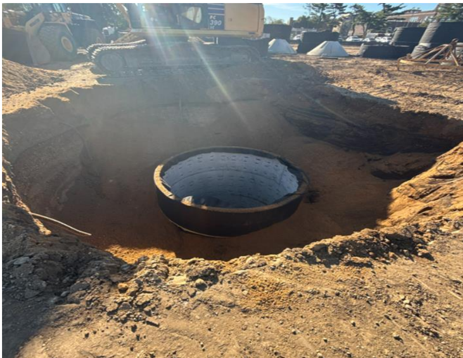
Hempstead ABGS MS – Drainage Pools
