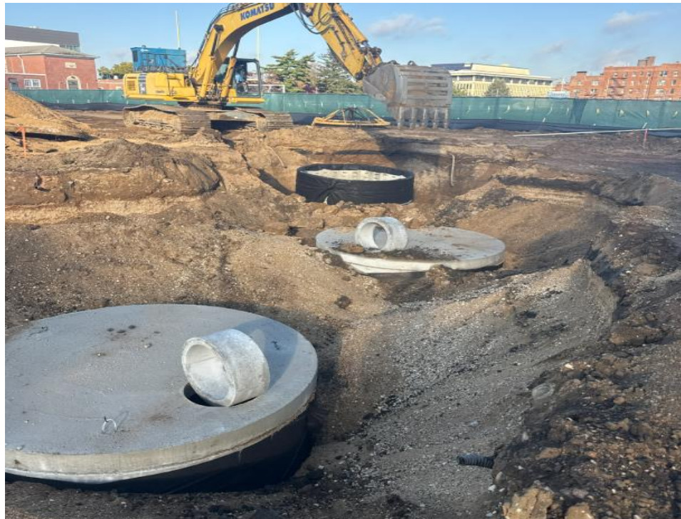
Hempstead ABGS MS – Drainage Pools
