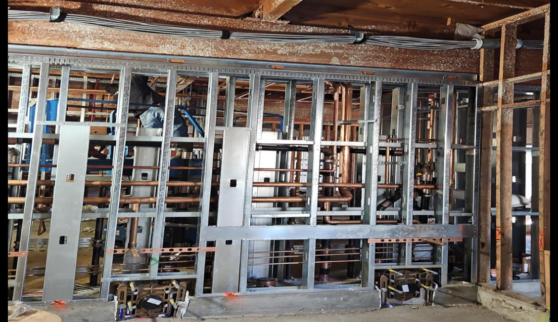
Metal Stud Framing November 2023
