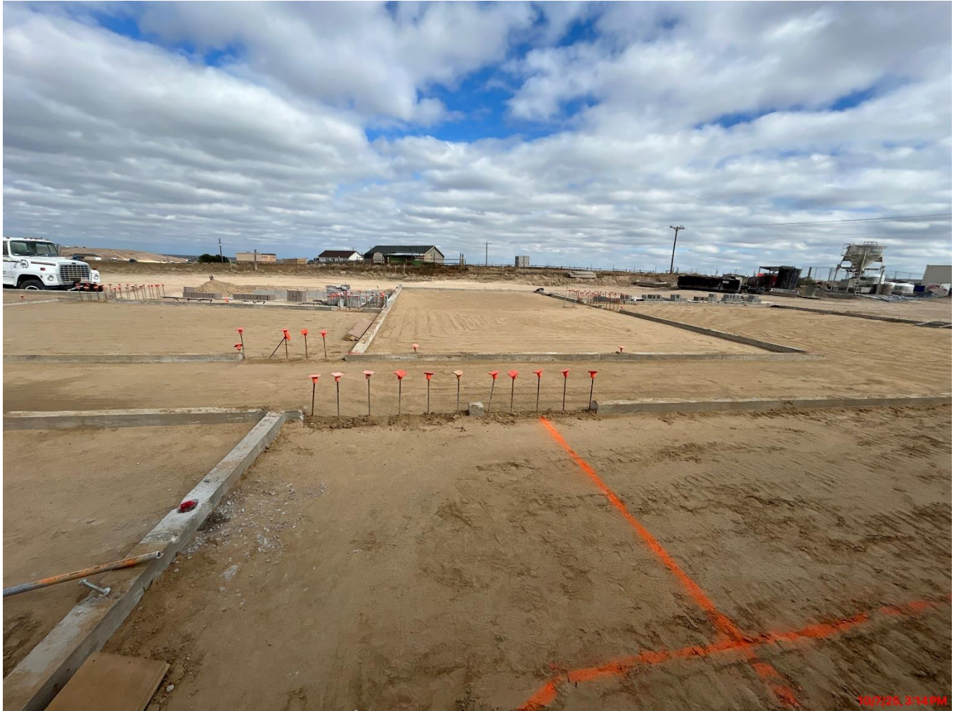
Foundation Back Fill
