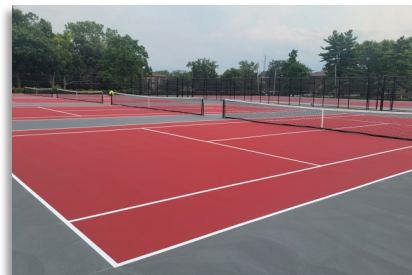
Canchas de tenis renovadas
