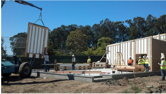
Instalación de Pared Modular – Escuela Intermedia Alta Loma
