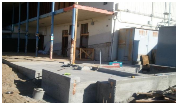
Construcción de Rampa Spruce – Diciembre 2013
