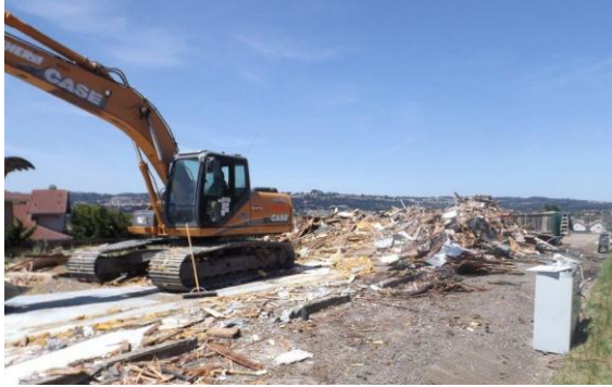
Demolición Escuela Intermedia Parkway - Mayo 2014
