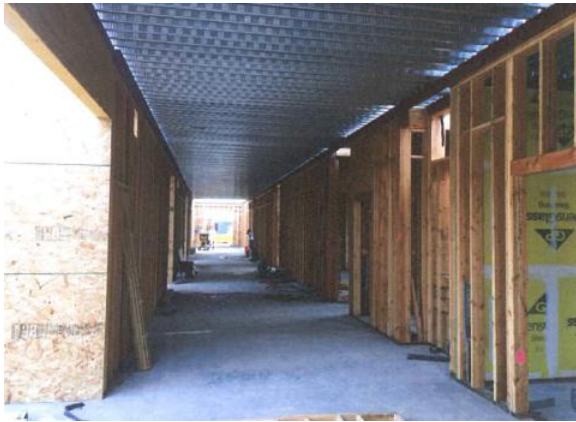
Edificio D Parkway Heights Primer piso – octubre 2014
