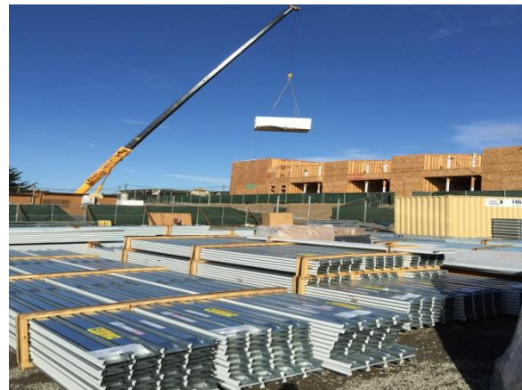
Instalación de Baños– Parkway – noviembre 2014
