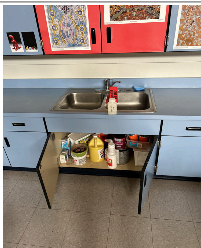
7/3/2024 - 1400-42 - Manor Hill - 001038-Room 31
