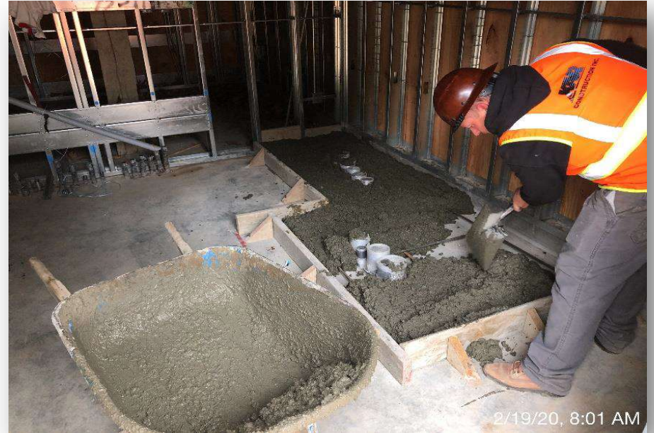
Concrete pad pour
