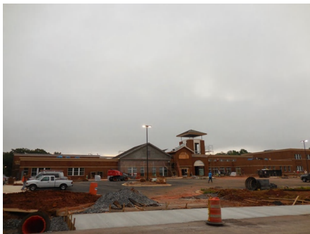
2). Site Under Construction - Jul 06, 2015
