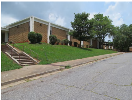
2). East Elevation - Jul 01, 2015
