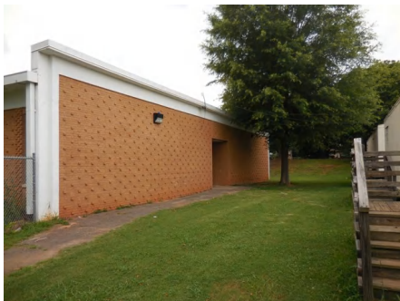
2). East Elevation - Jul 01, 2015
