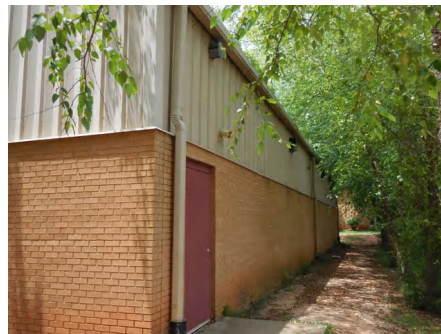
3). East Elevation - Jul 01, 2015
